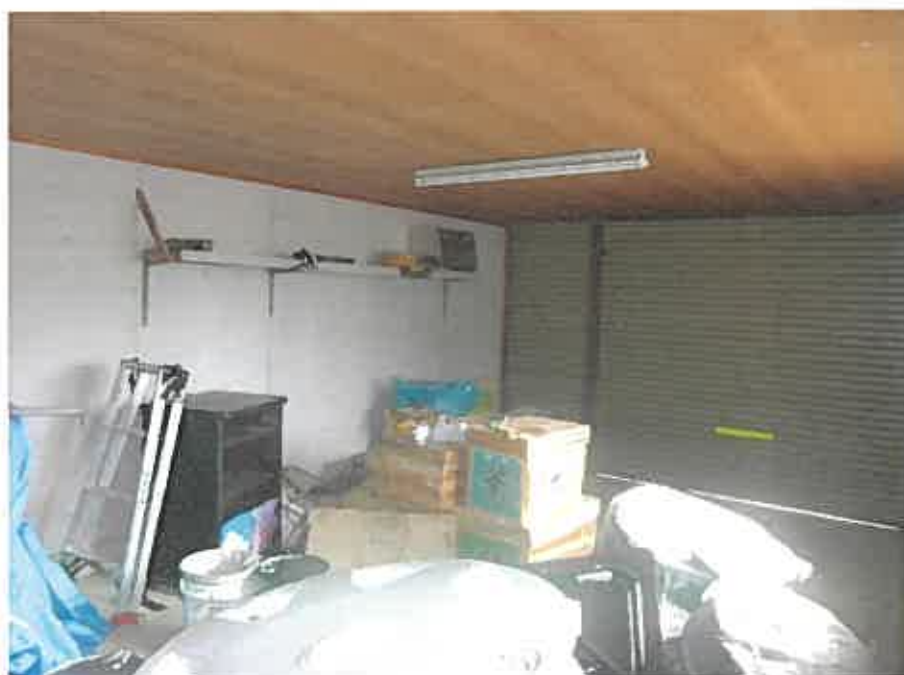
写真 6 附属建物の内部状況
