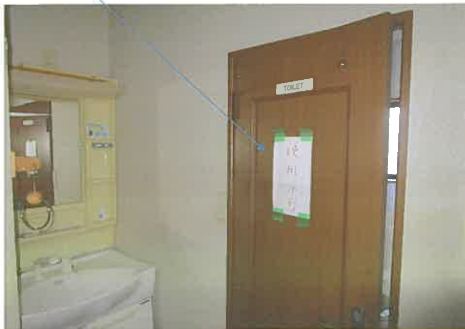
写真⑯ 「使用不可」の張り紙(WC)
