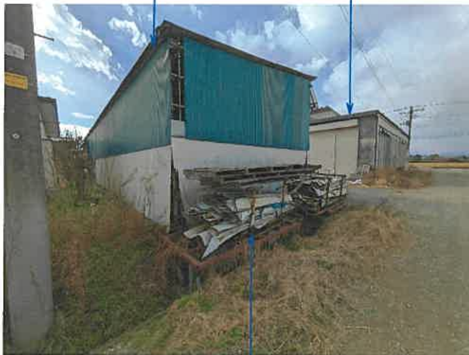
水路敷に無断で置かれている廃材
