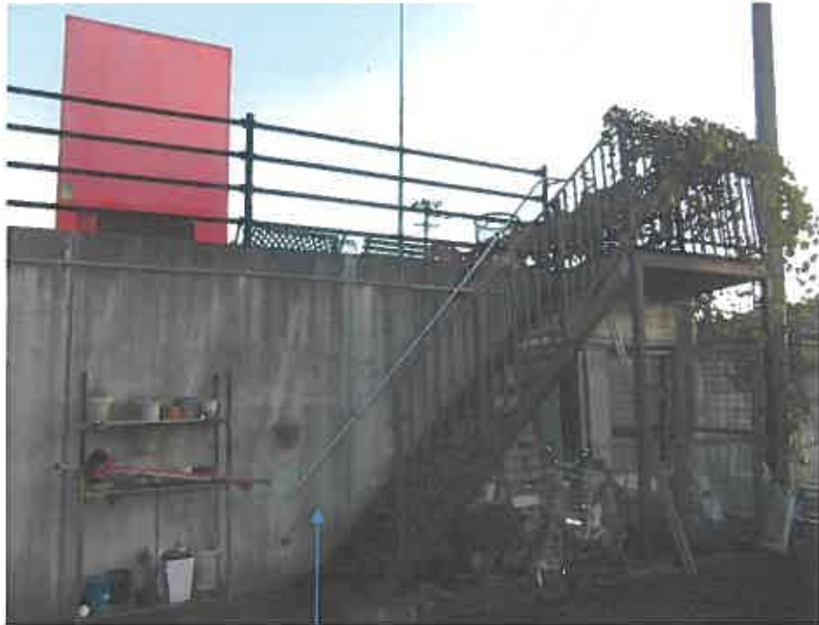
擁壁・階段(構築物)及び階段
