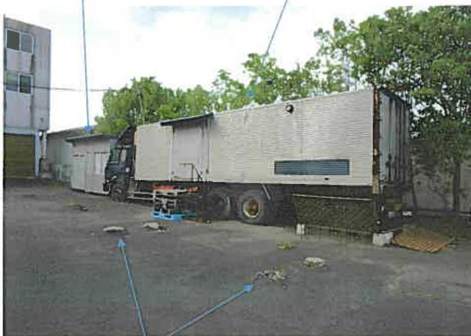
地盤沈下の形跡(マンホールの浮き上がり)
