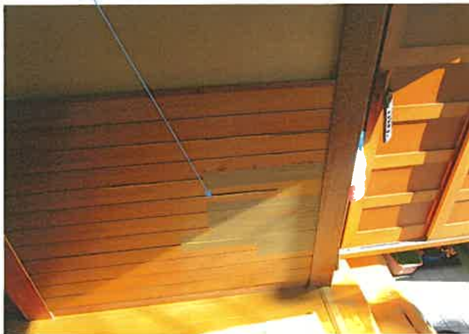
写真⑦ ペットのネコによる疵の補修跡
