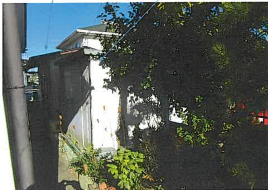
写真⑧ 物件2(未登記附属建物) スチール製物置(動産)
