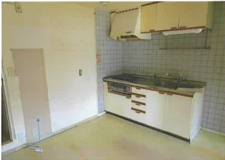
内壁のクロスが貼られていない状態
