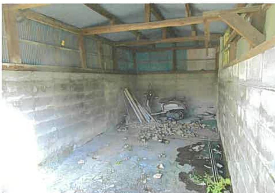
写真⑩ 物件2(附属建物符号1)の内部の状況
