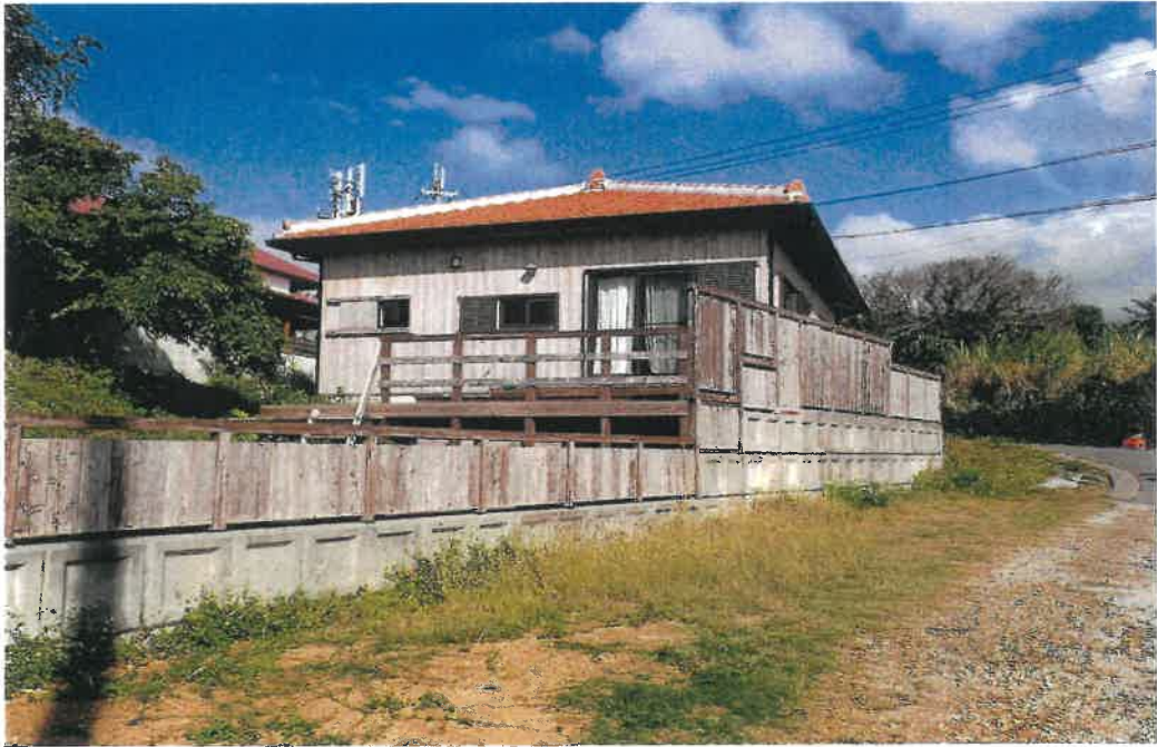
本件建物の南側の状況
