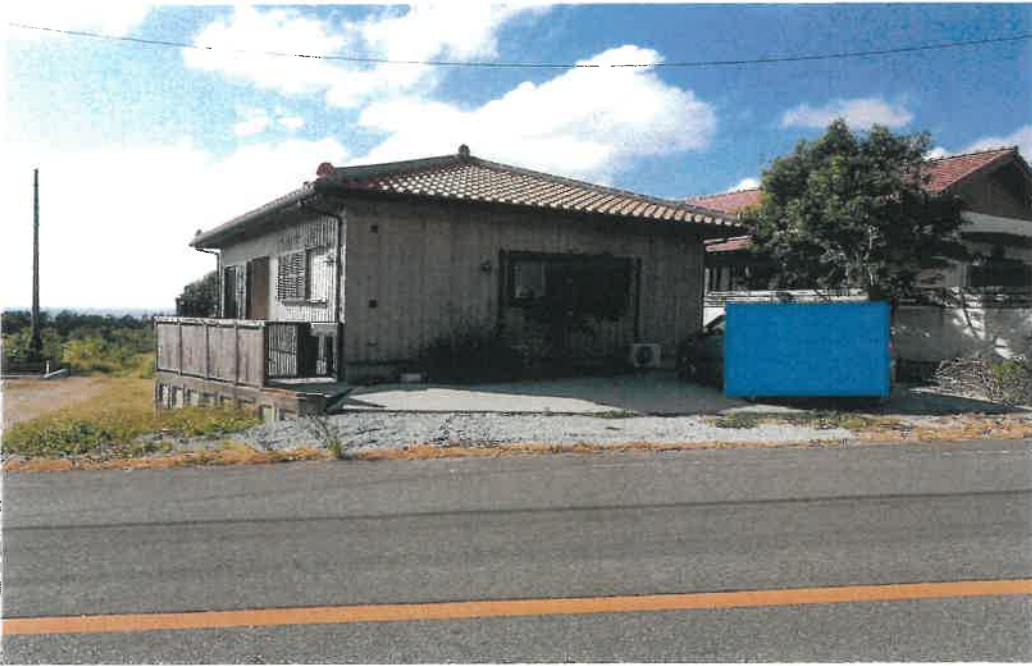
本件建物全景
