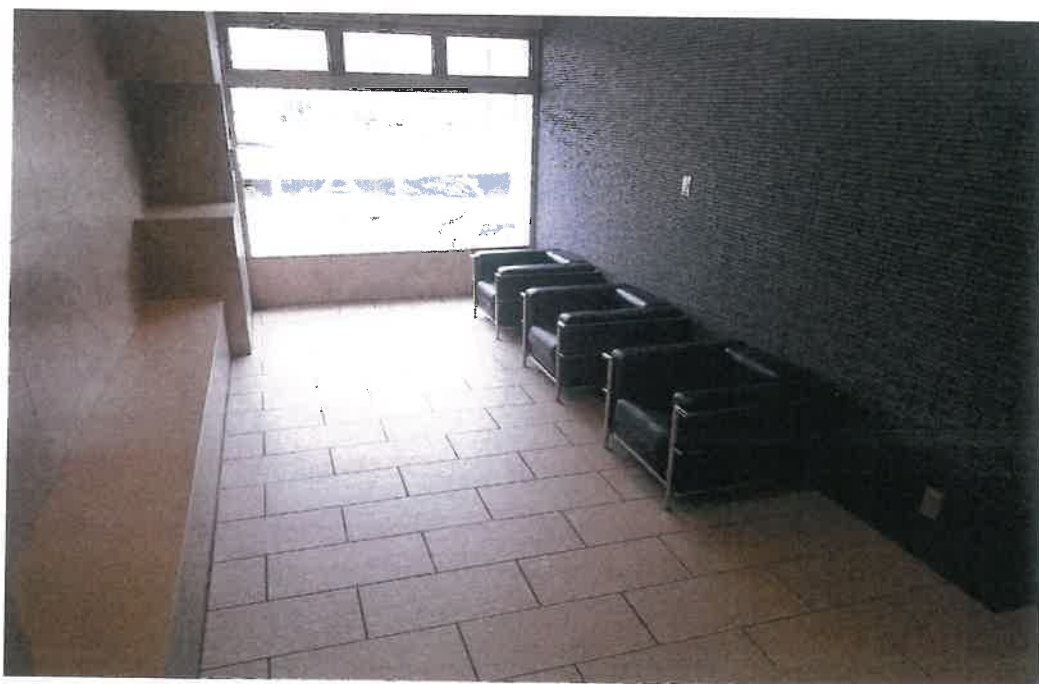
エントランスの状況
