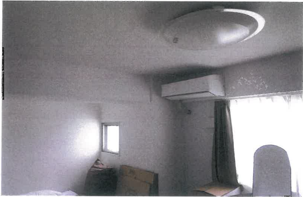
本件建物内部
