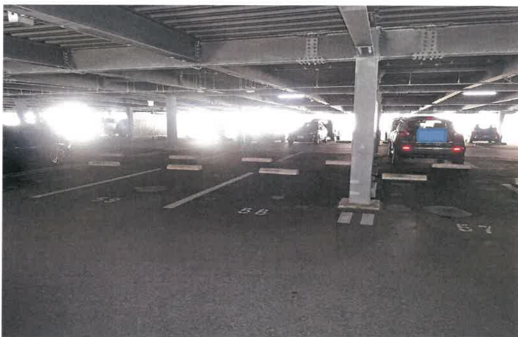
自走式立体駐車場
