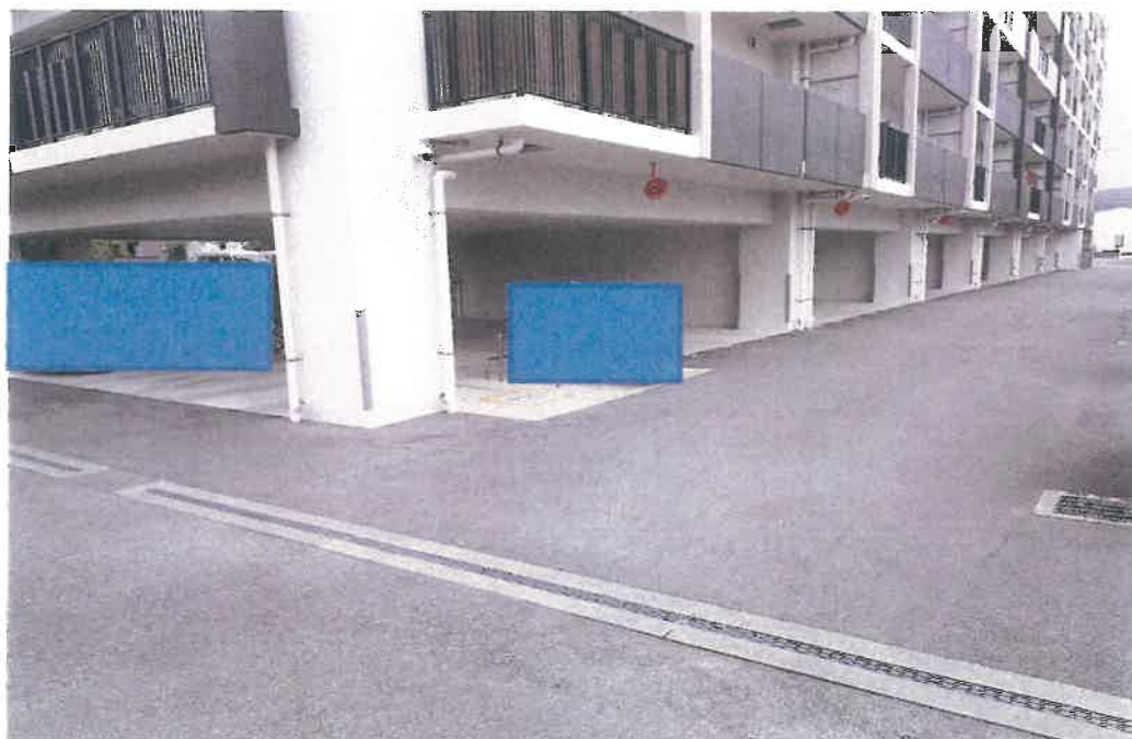
駐車場の状況
