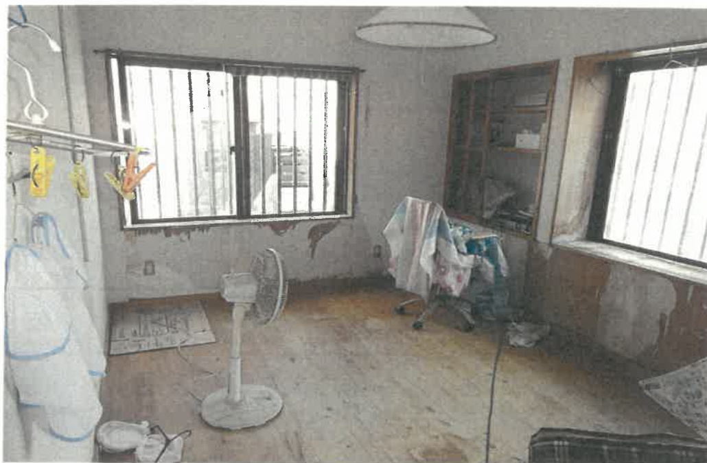
物件3の室内(2階の状況)
