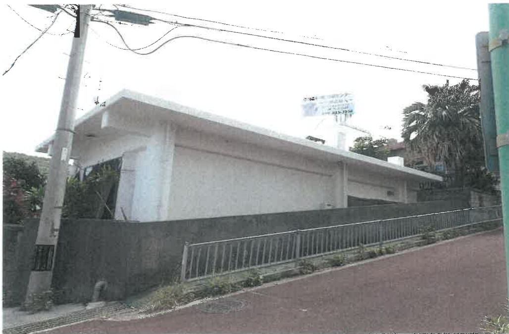
接面道路の状況
