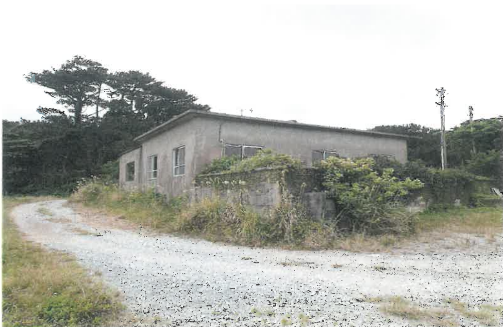
目的外建物1付近の状況
