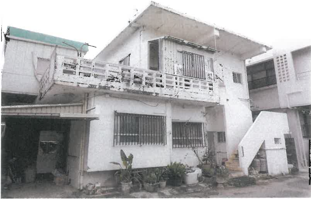
本件建物全景
