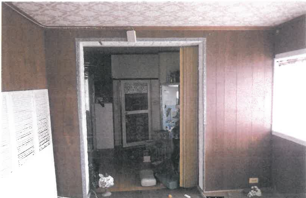
本件建物内部
