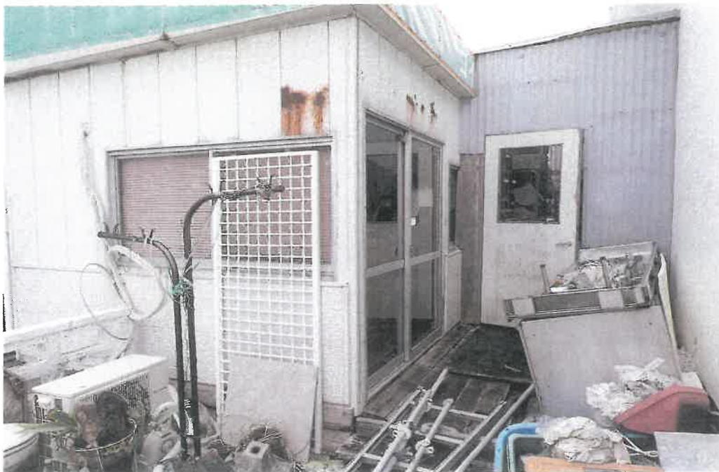
2階プレハブの状況
