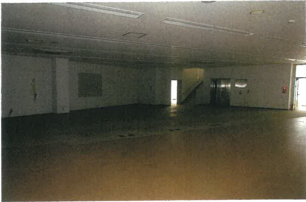
室内(1階:事務室)
