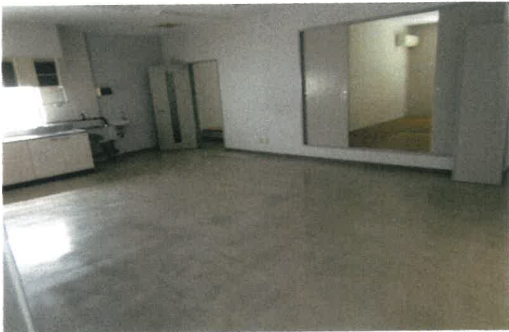
室内(2階:休憩室)
