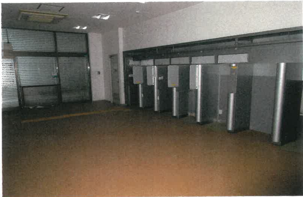
室内(1階:玄関ホール部分)
