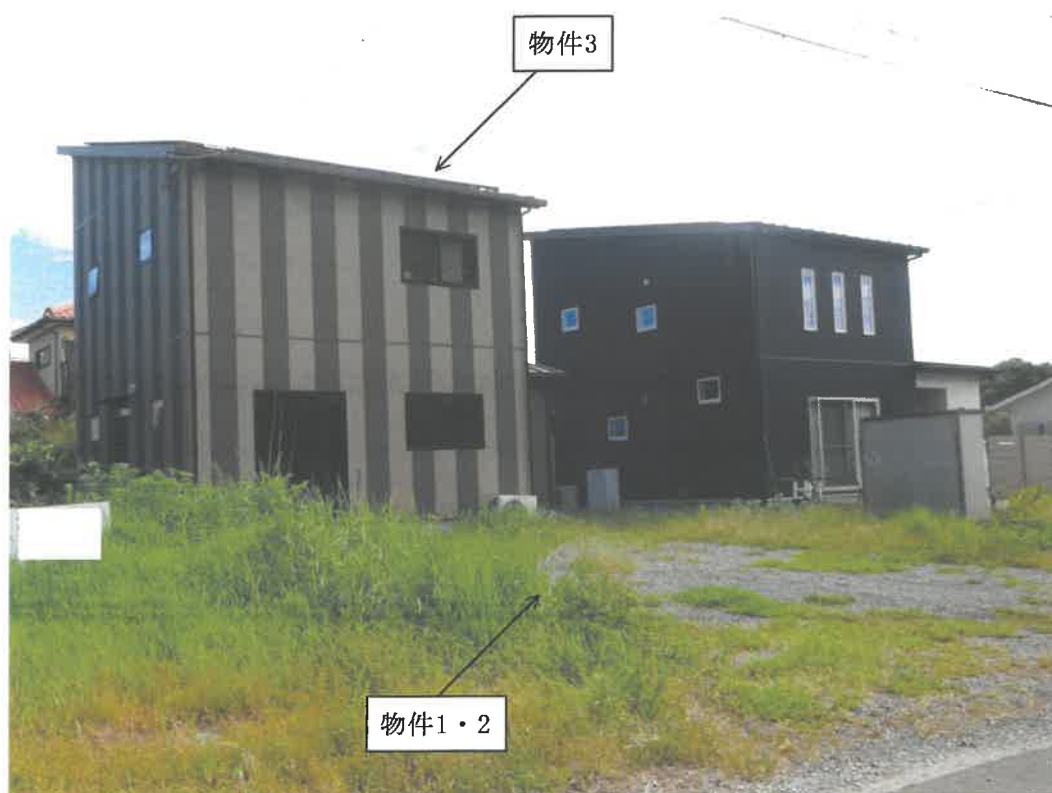
現況写真 南西方から撮影
