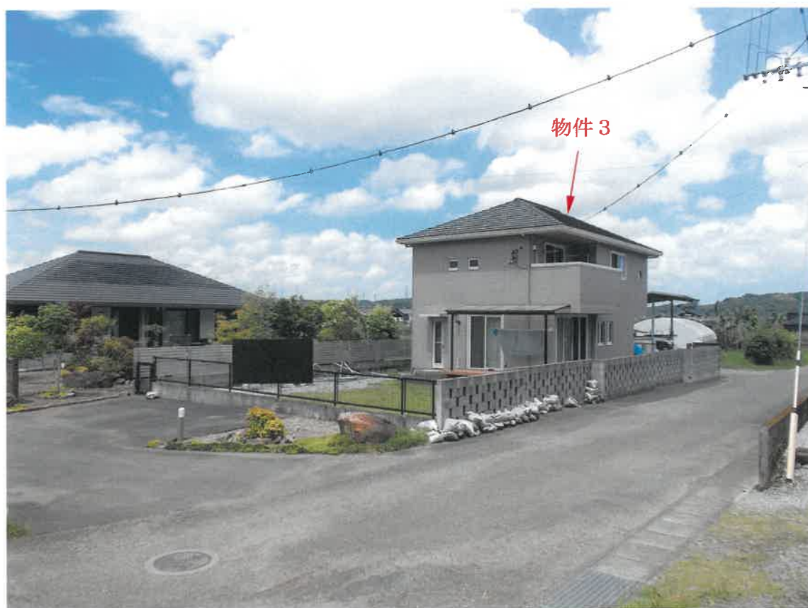
南西方より撮影
