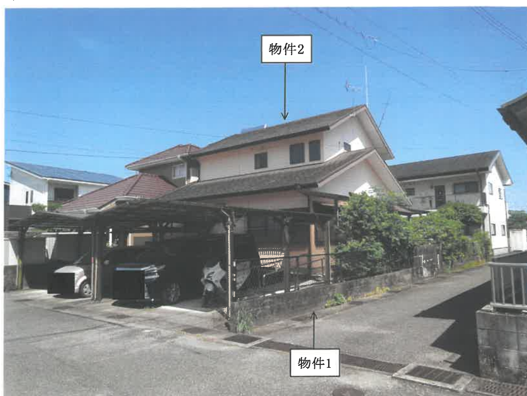
現況写真 北西方から撮影
