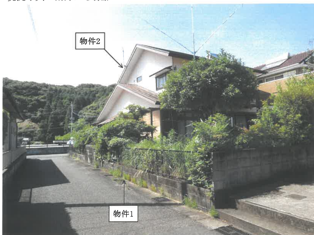
現況写真 南方から撮影
