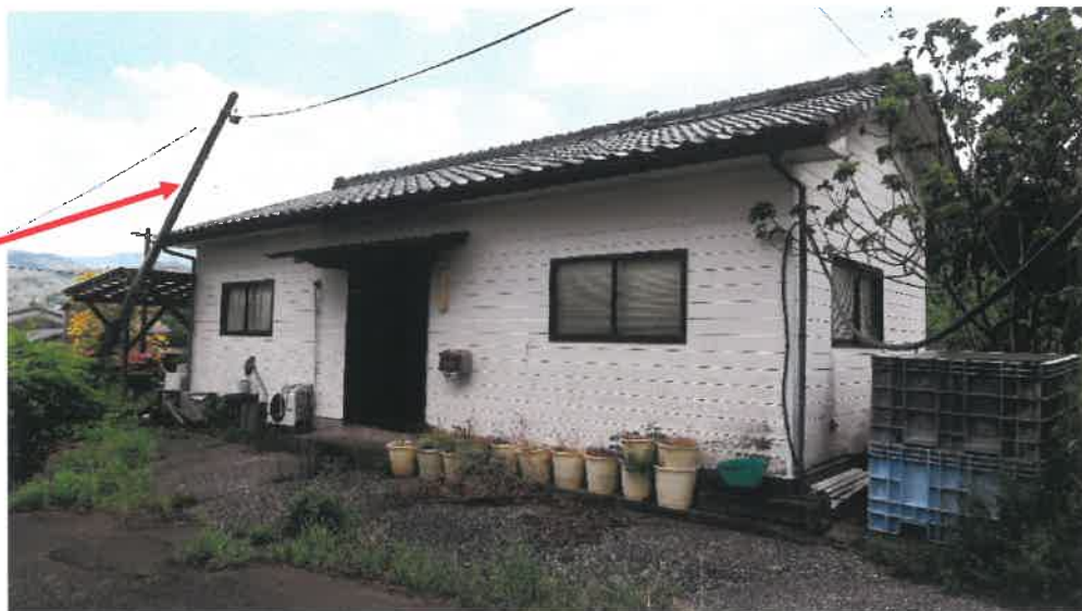
物件 5 建物 (北西側)
