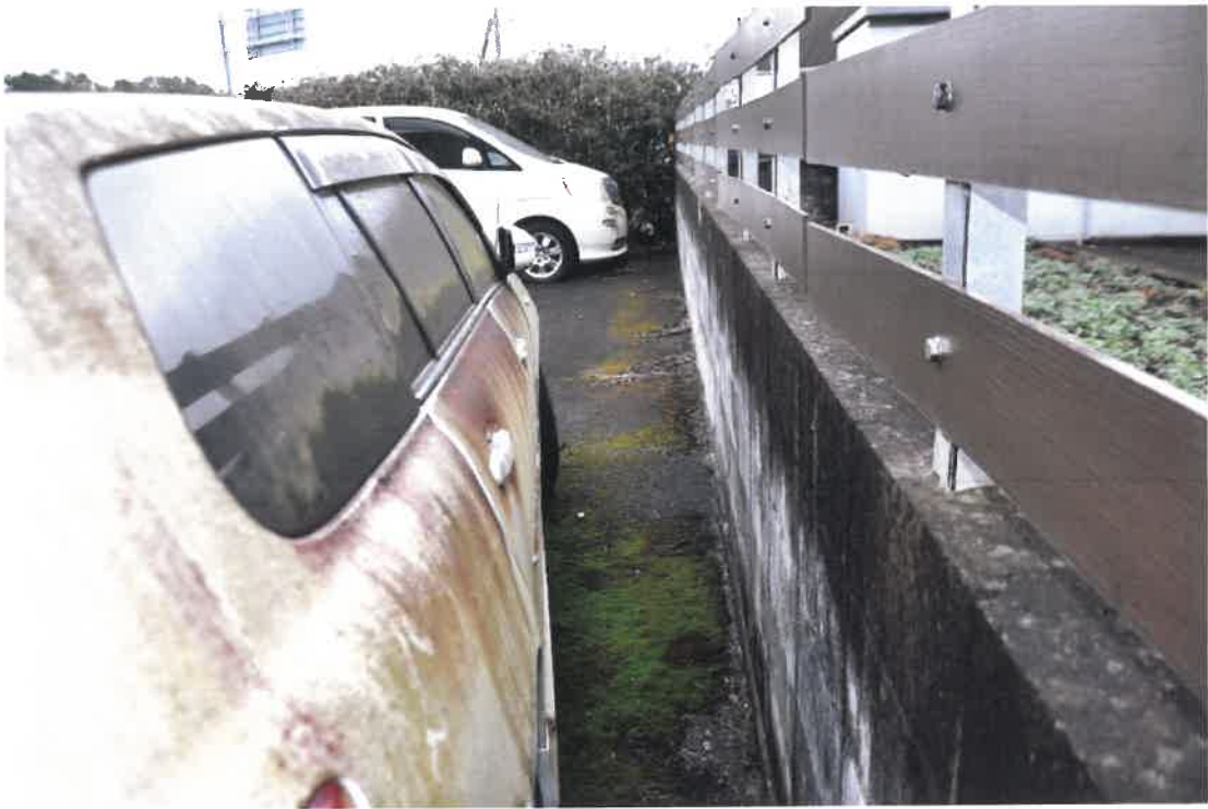
写真③ 北東側隣接地との 境界付近の状況
