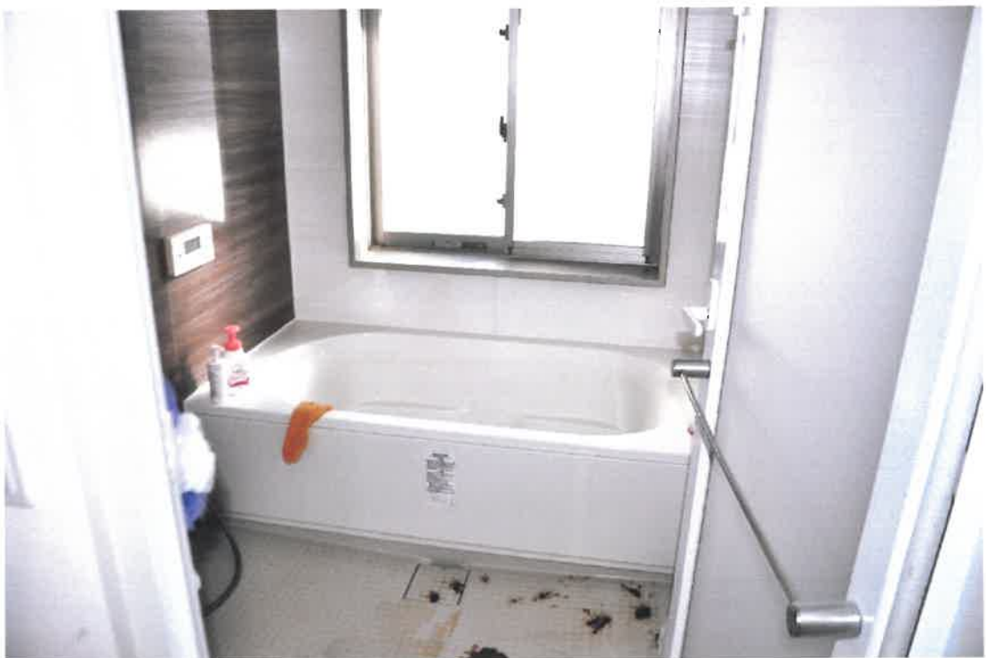
床の黒点は汚物
