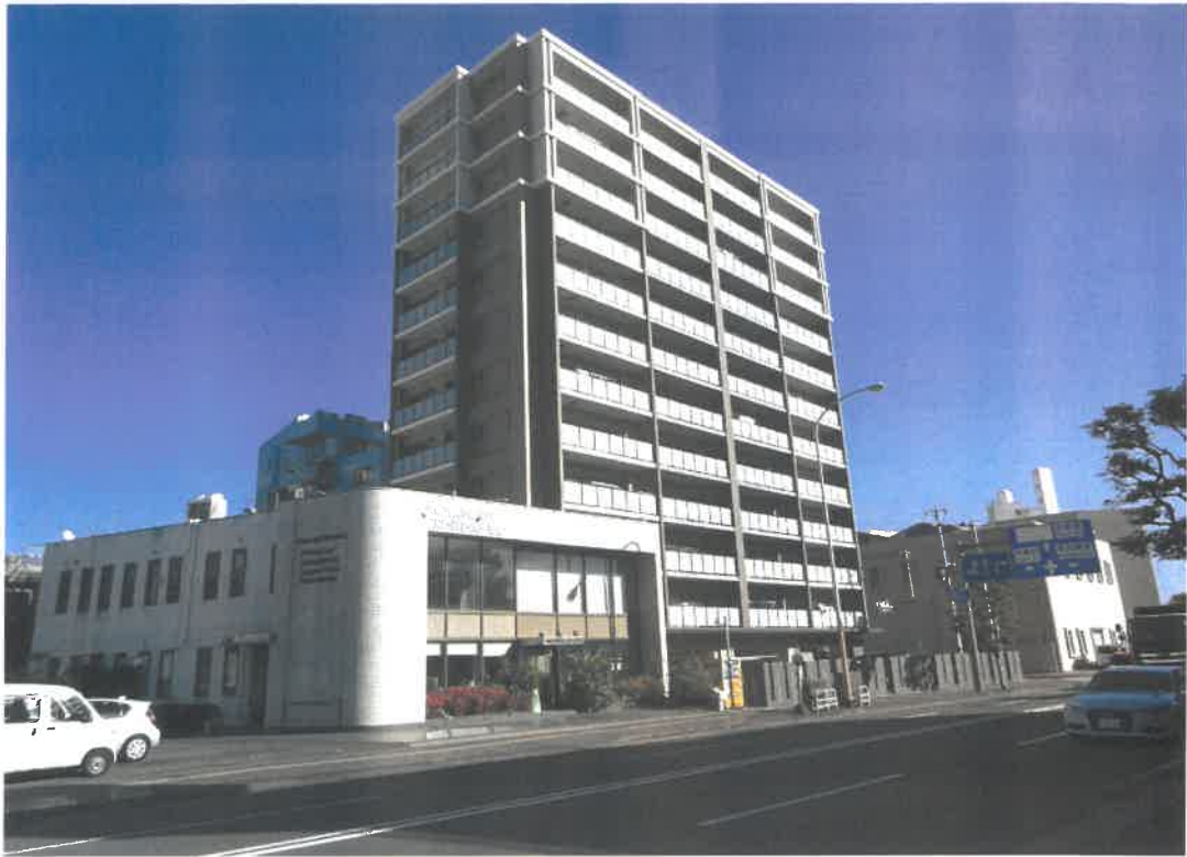
現況写真 南西方から撮影
