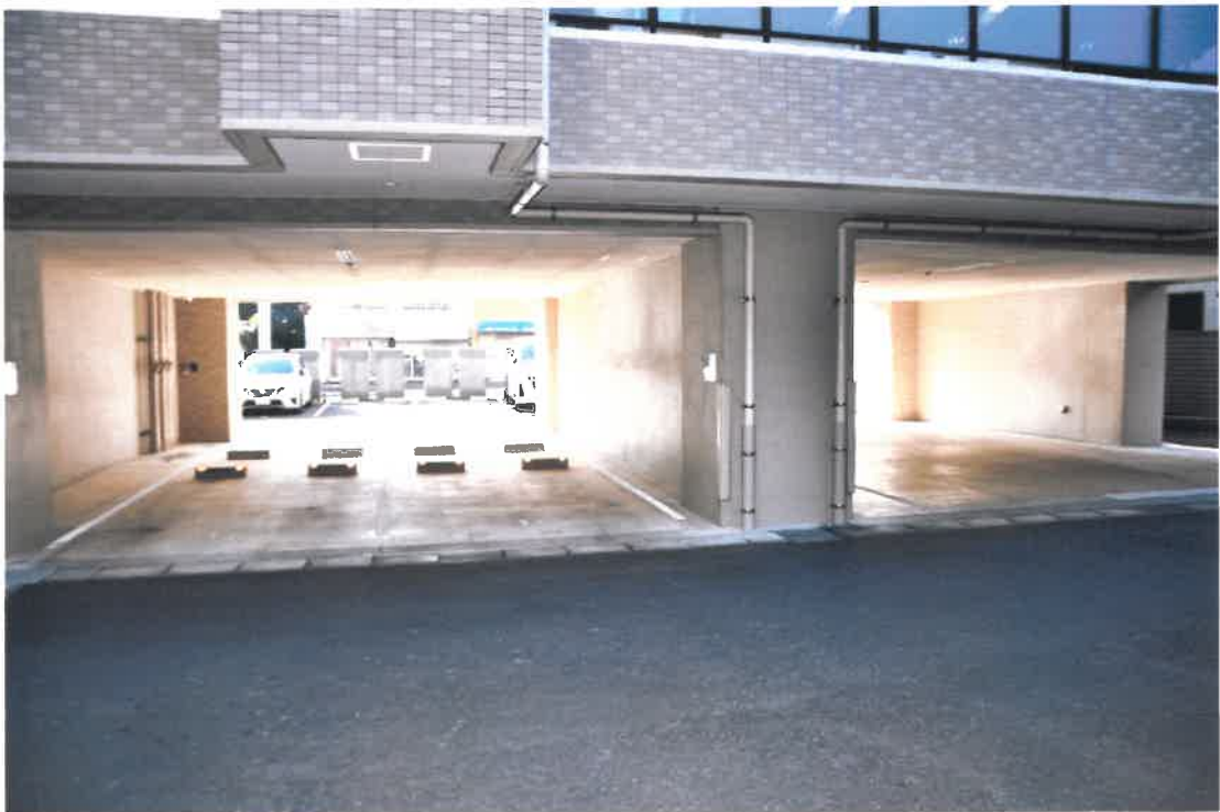
屋内平置き駐車場
