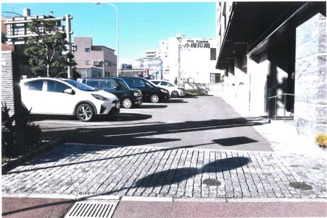
屋外平置き駐車場
