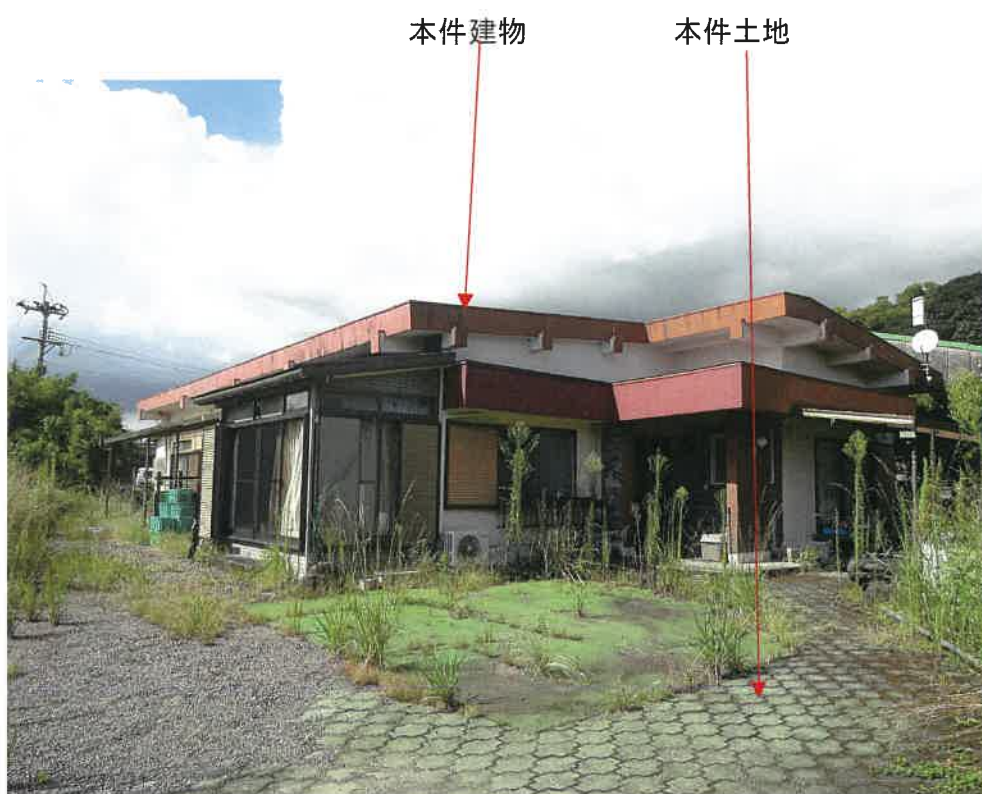
写真1 本件土地建物外観
