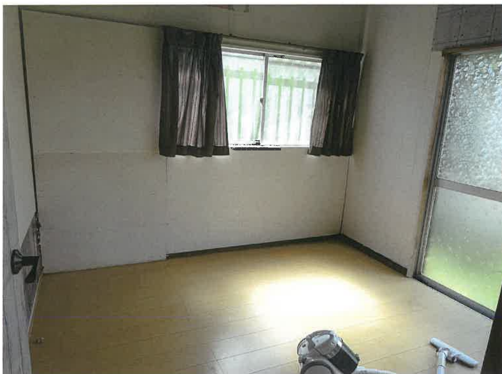
写真22 クロスの剥がれ等
