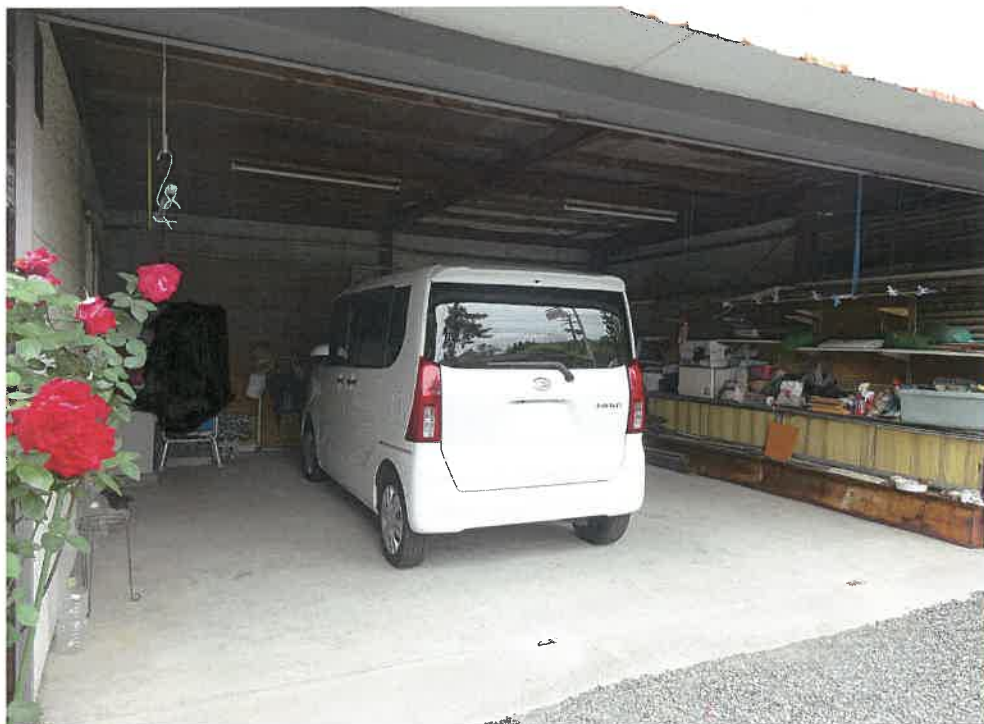
写真10 本件建物内部
