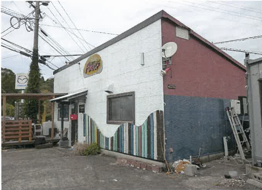
⑤対象建物（南東）
