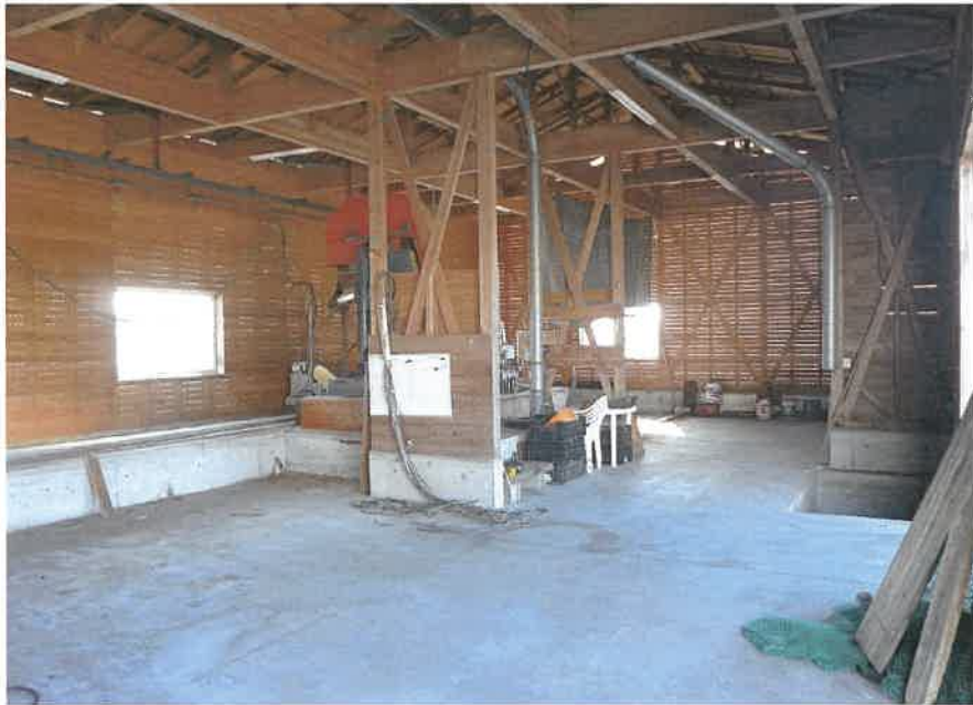
⑪本建物内部
