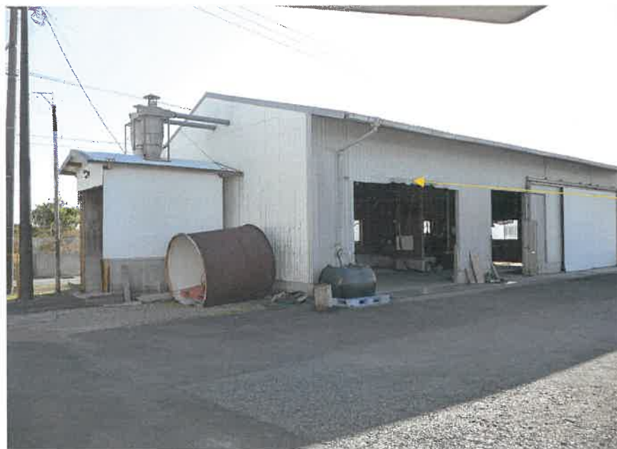
⑨本建物（北西）
