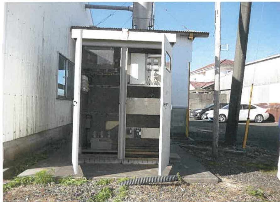
⑥変電設備庫（設備なし）
