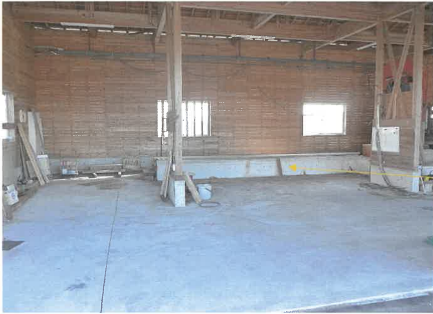
⑩本建物内部
