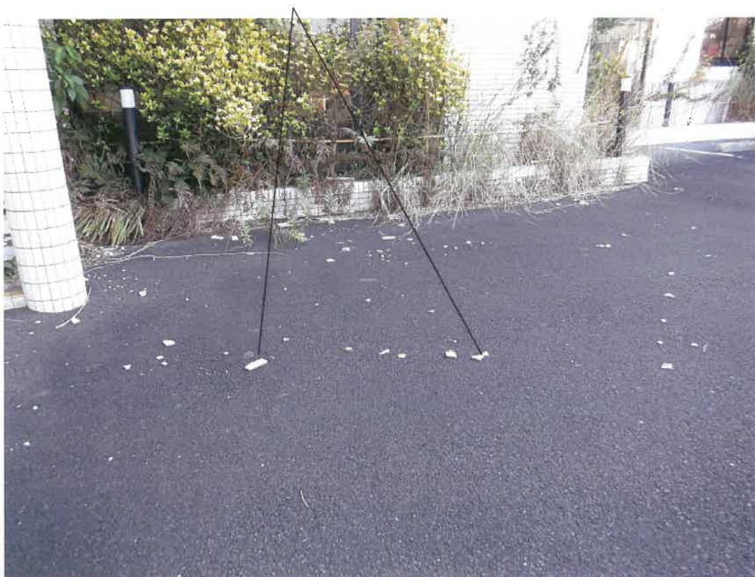
崩落した外壁タイルの残骸
