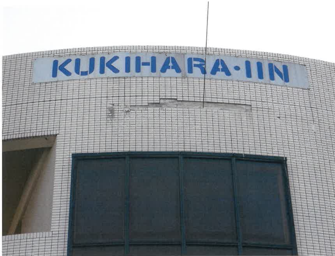
崩落した外壁タイルの残骸
