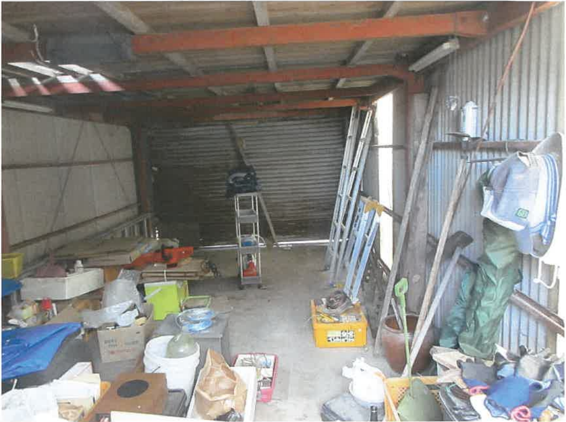
写真 1 1 及び 1 2 は符号 1 の附属建物の内部
