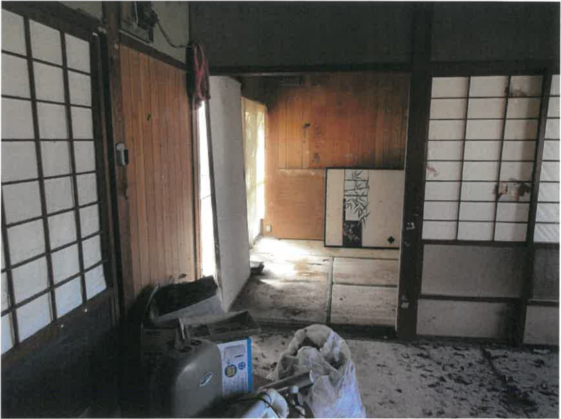
写真 2 5 乃至 2 8 は符号 5 の附属建物内部
