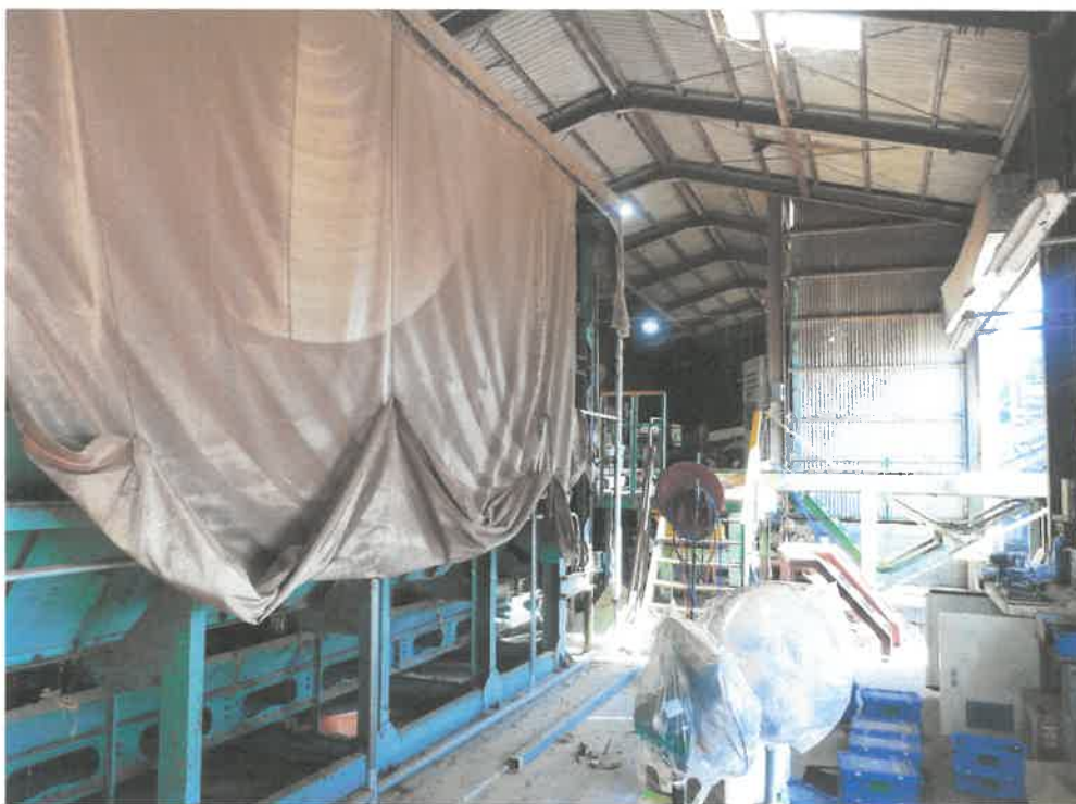
物件7（主である建物）の内部状況
