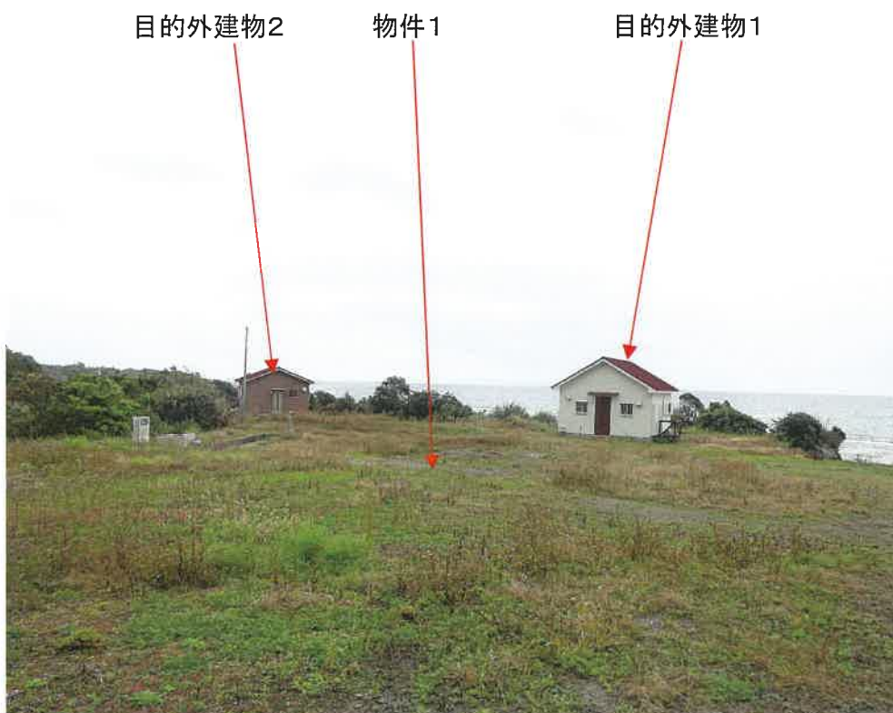
写真6 本件土地上に存する目的外建物
