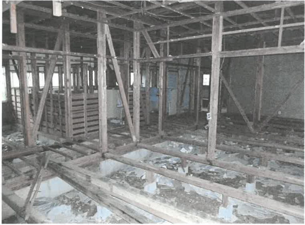
物件4 建物内部
