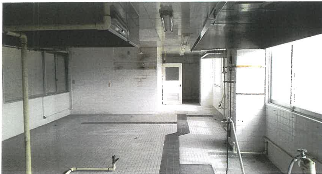
物件 3 5 階内部状況
