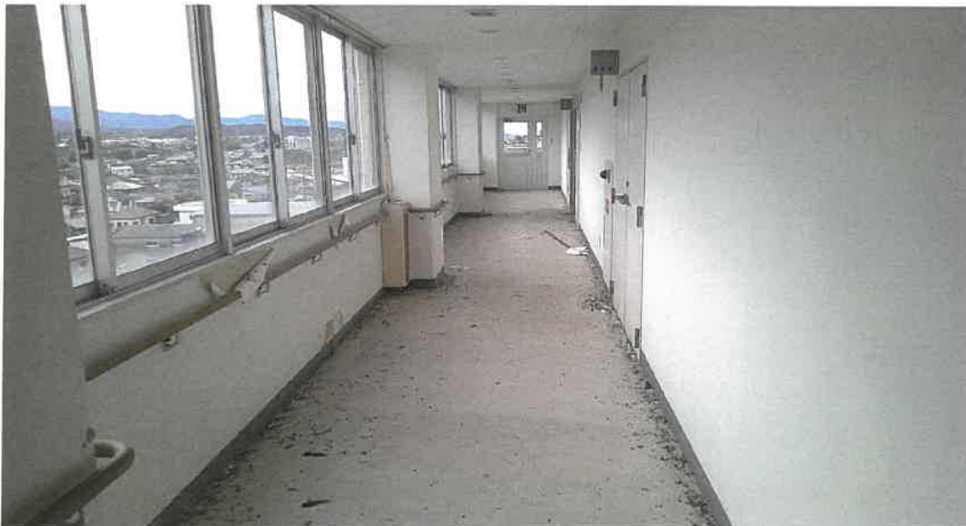
物件 3 6階内部状況
