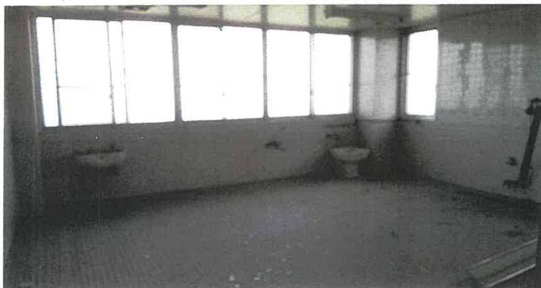
物件 3 4 階内部状況
