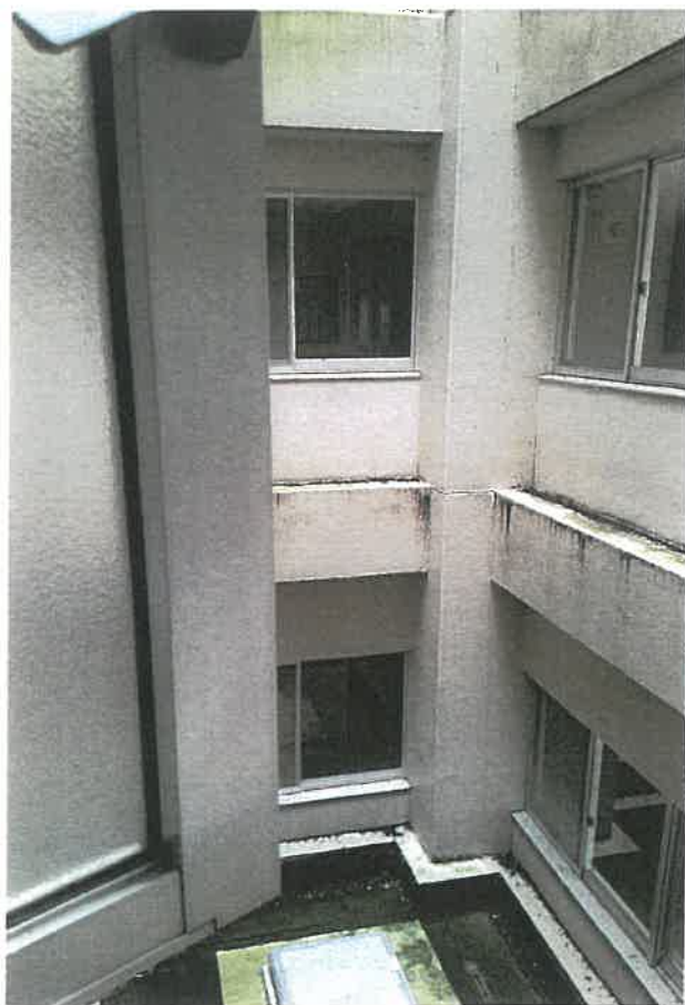
物件 3 3 階内部状況
