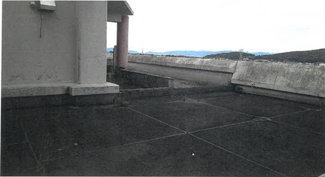
物件 3 6階内部状況
