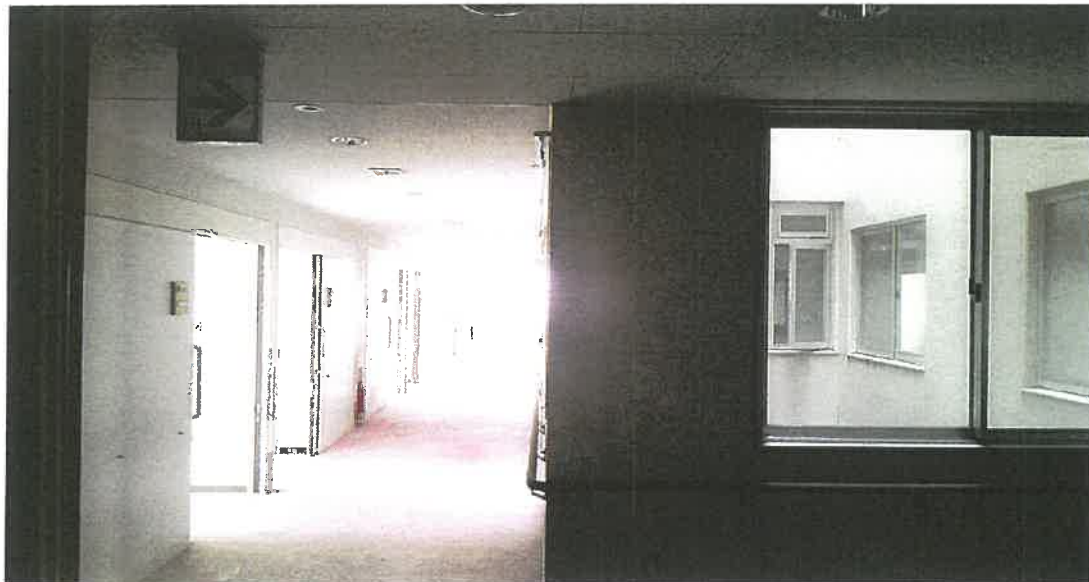
物件3 3階内部状況
