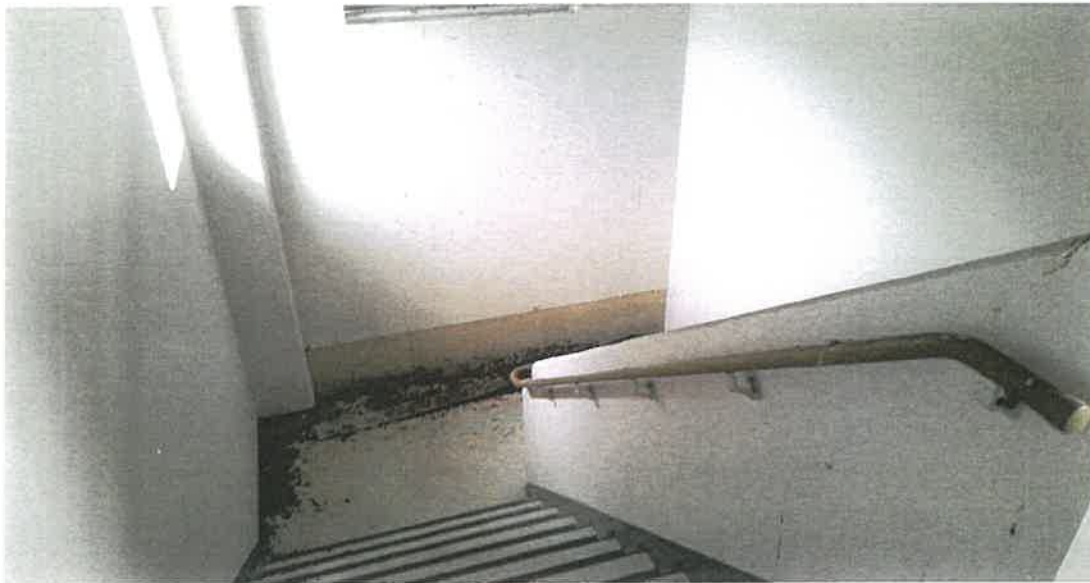
物件3 7階階段状況
