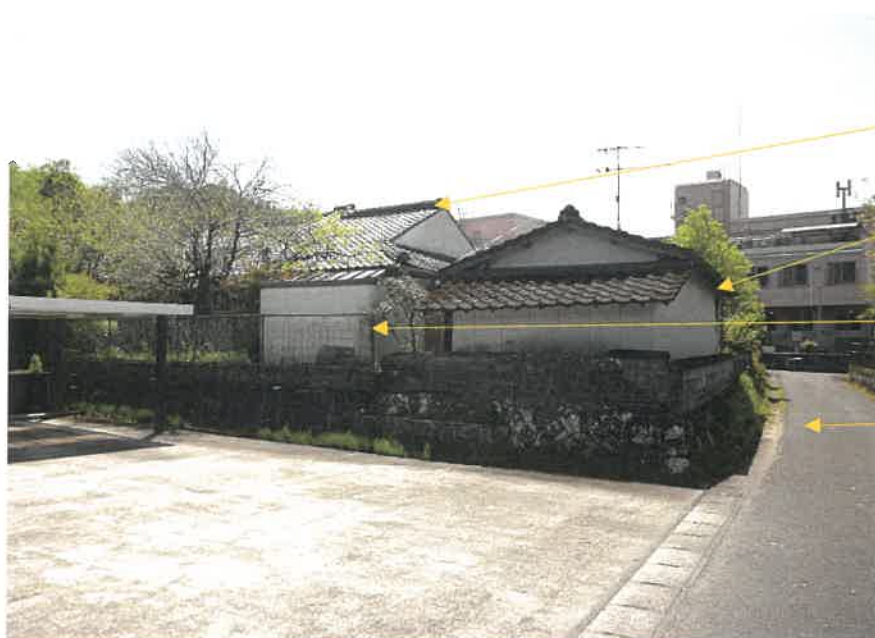
④対象物件（北西→南）
