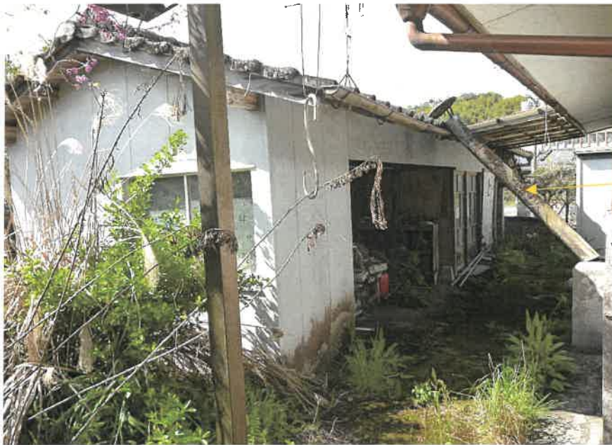
⑪物件 3 附属建物符号 1 (外観)
