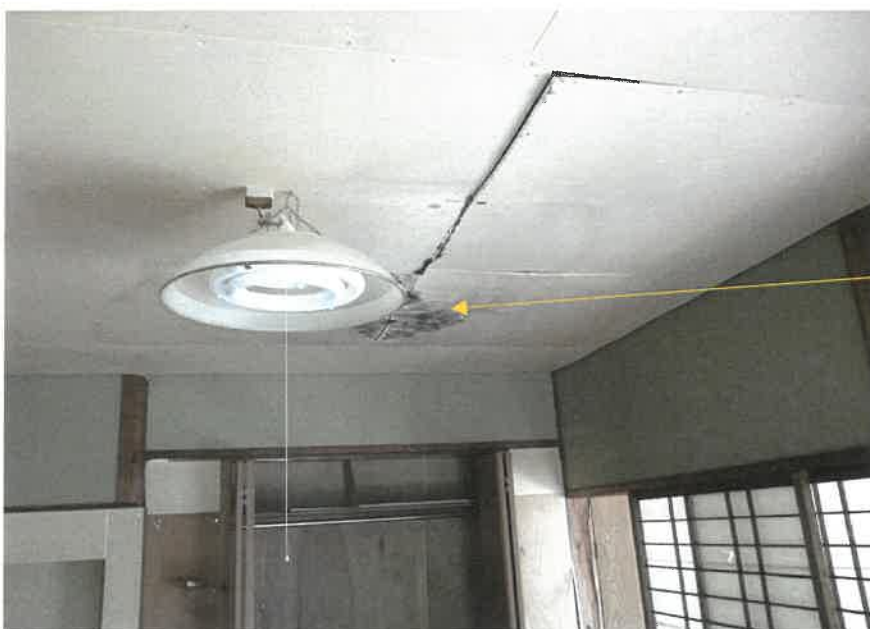
⑨物件2主たる建物 洋室天井
