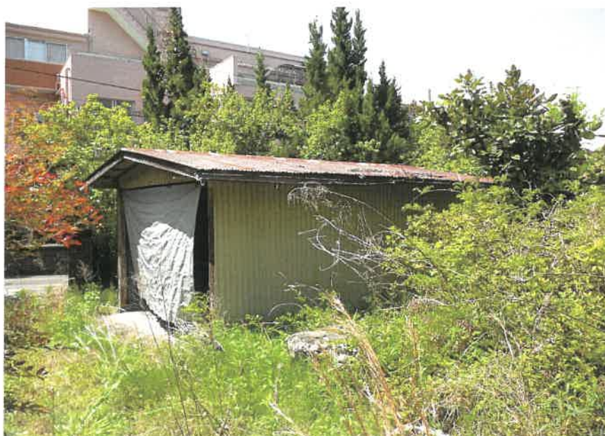
⑫物件 2 附属建物符号 1 (車庫)
