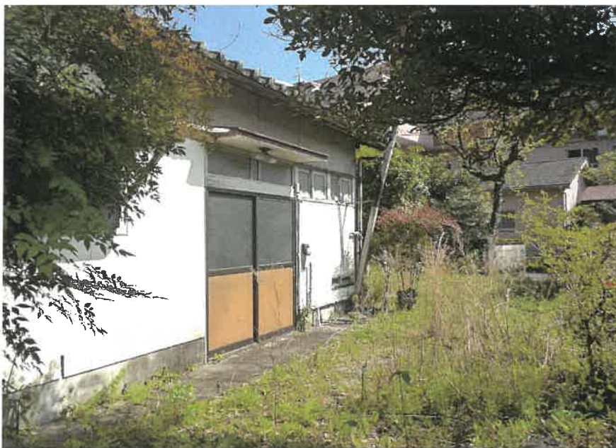
⑧物件2主たる建物 （外観）
