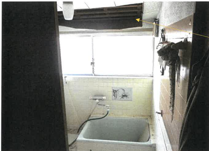
⑪物件 3 主たる建物 浴室
