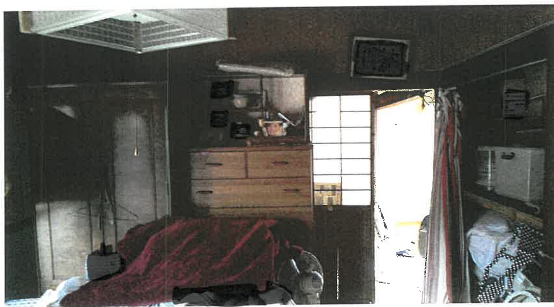
物件 6 主たる建物 内部状況
