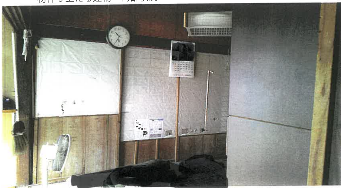
物件 6 主たる建物 内部状況
