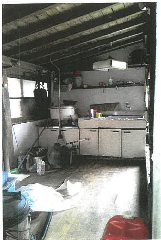
物件 6 主たる建物 内部状況
