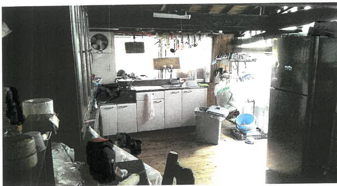
物件 5 内部状況
