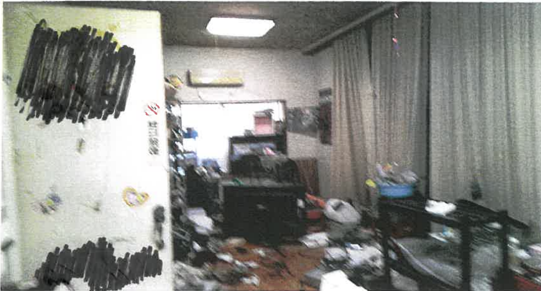
物件 2 2 階内部状況
