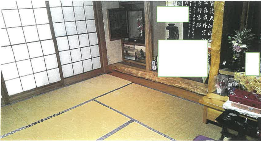
物件 2 1 階内部状況
