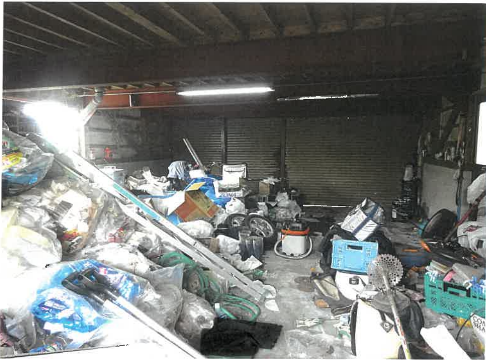
写真22 附属建物内部(2階)
