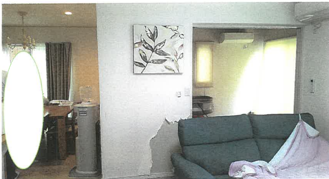
物件 2 1 階内部状況
