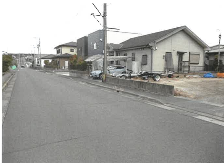
②対象物件全景（北西）
