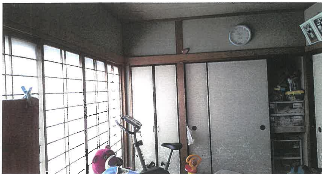
物件 2 1 階内部状況
