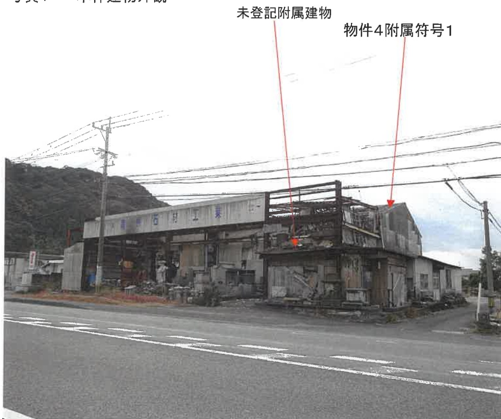
写真1 本件建物外観
