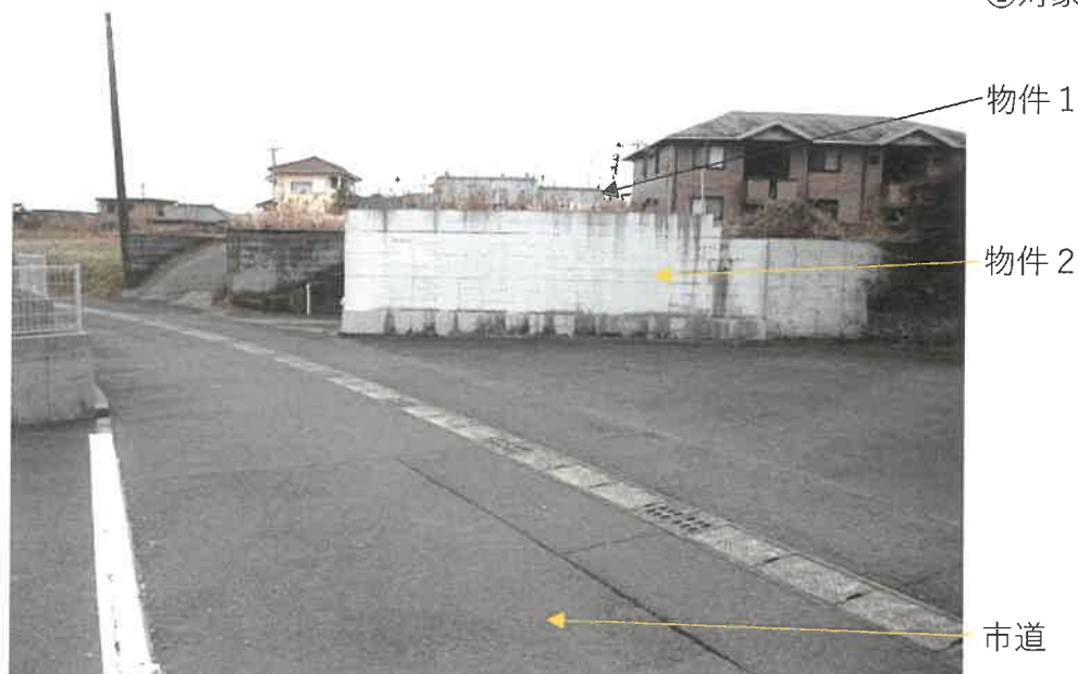
①対象物件全景（北西）
