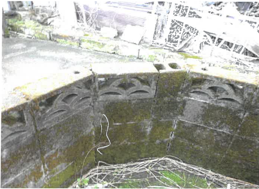
④南東端隅切り部分
