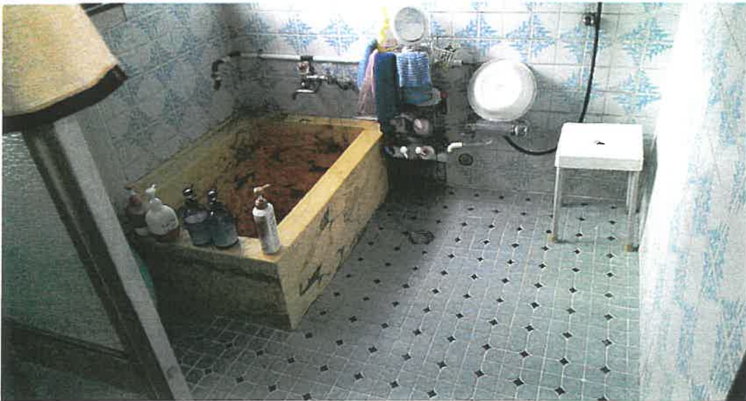
物件2 1階内部状況
