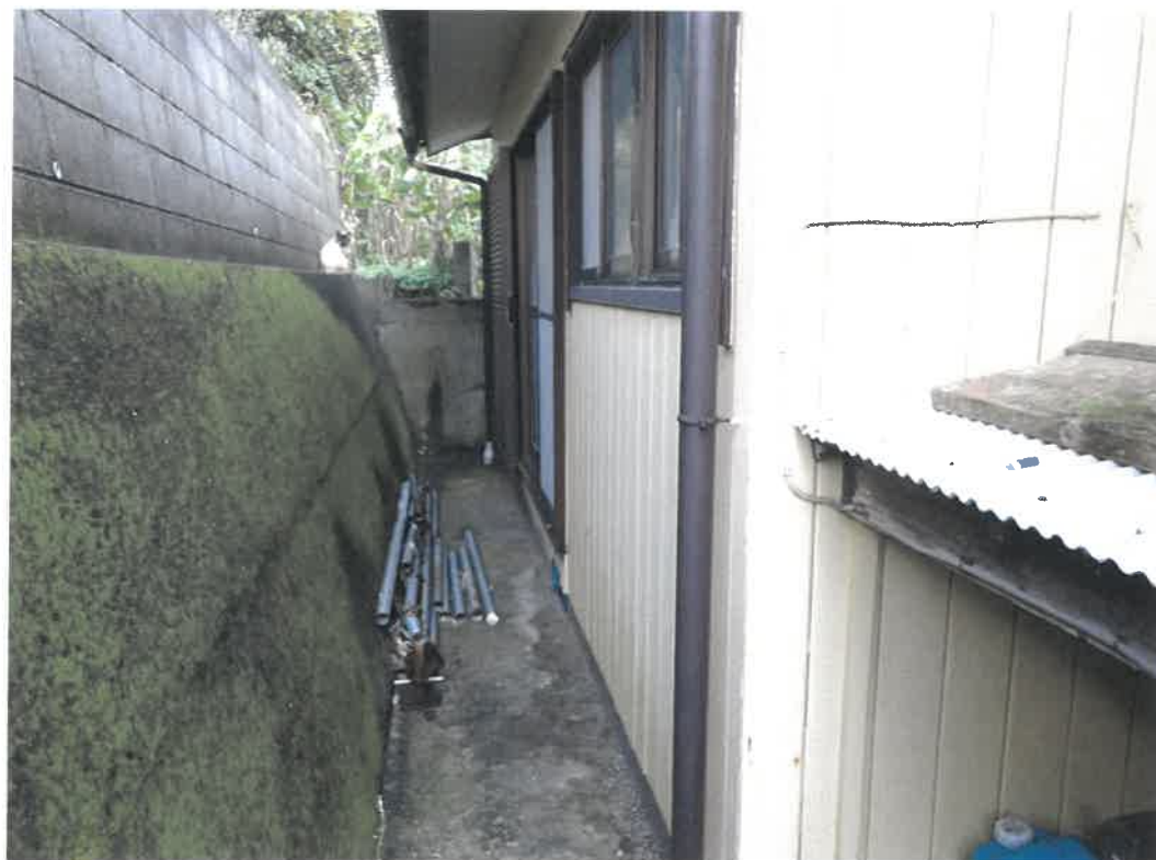
写真③ 北東部外壁面
