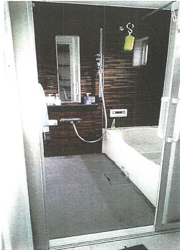
物件2 内部状況
