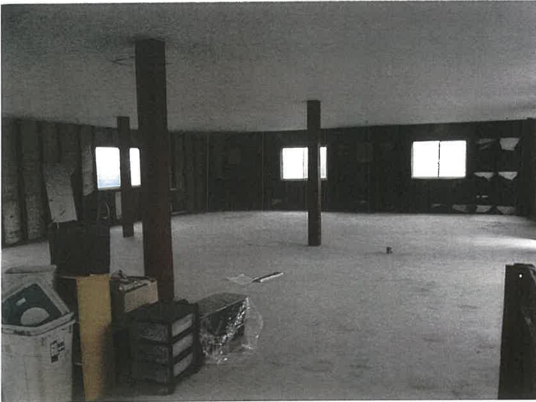
物件3 2階内部状況
