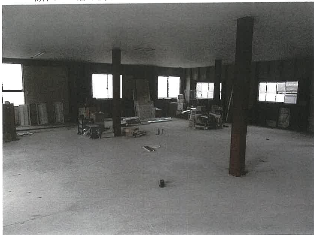
物件 3 2階内部状況
