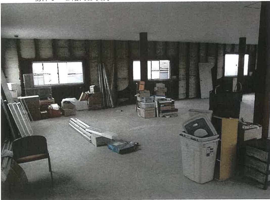
物件3 2階内部状況
