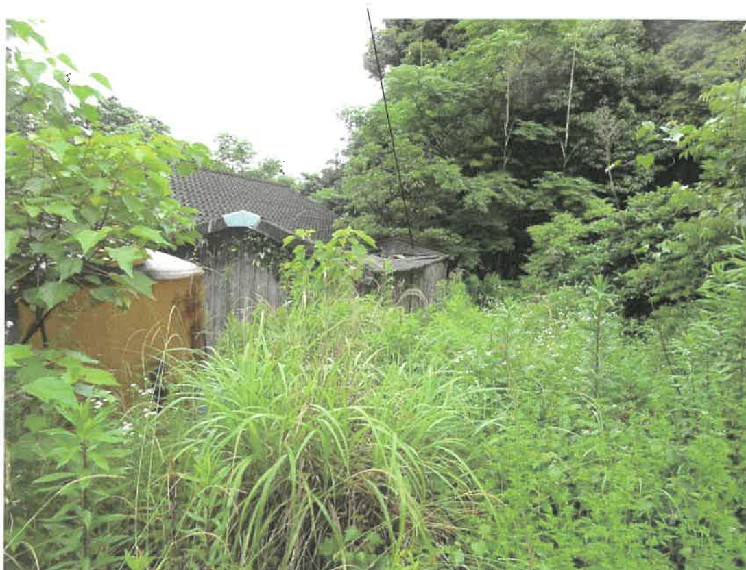
物件 2 土地上の工作物(倉庫)
