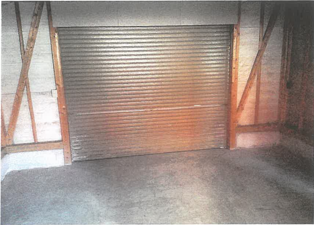
物件 2 内部状況
