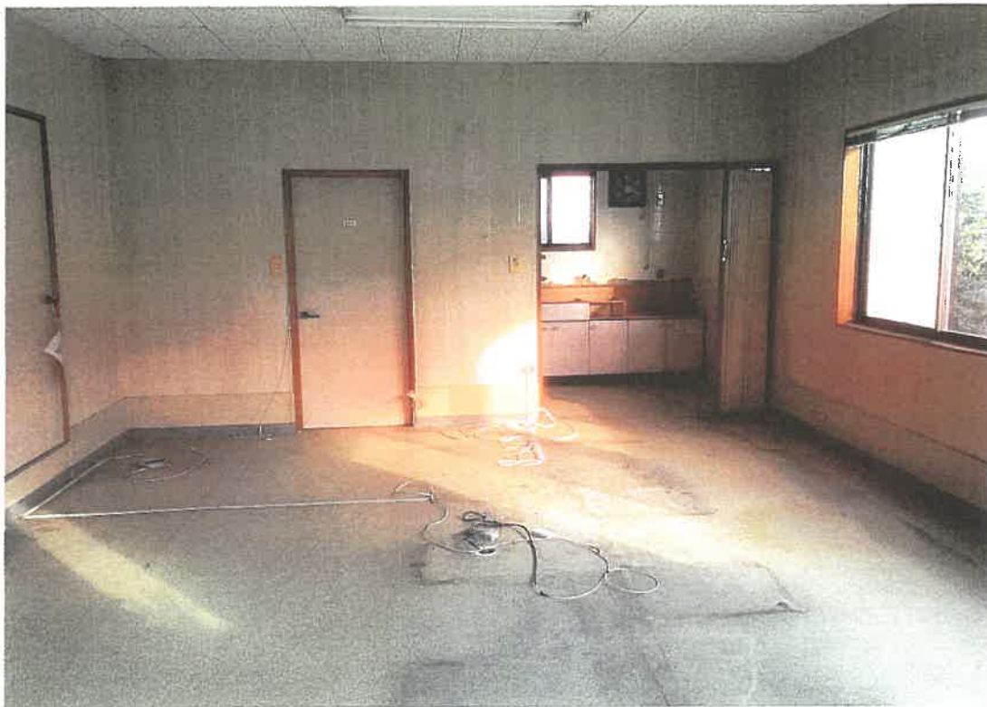
物件 2 内部状況
