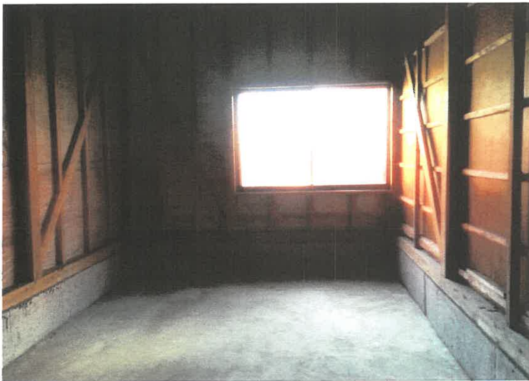
物件 2 内部状況
