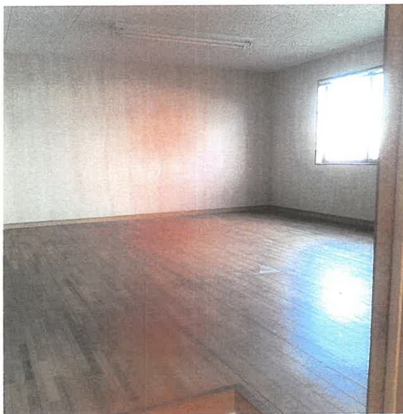
物件 2 内部状況
