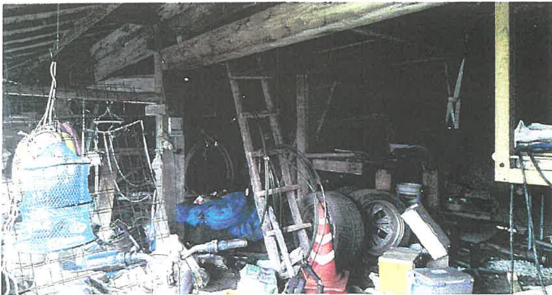
物件3附属建物符号1建物内部状況
