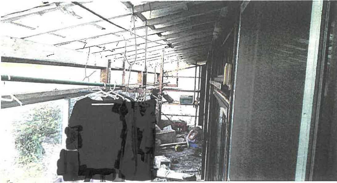
物件3主たる建物内部状況
