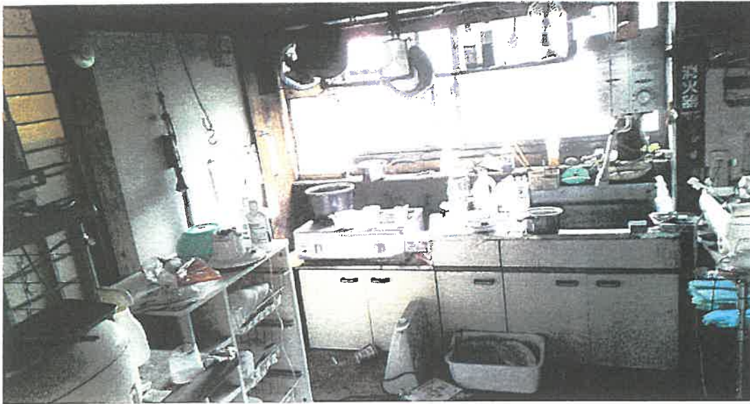
物件3主たる建物内部状況
