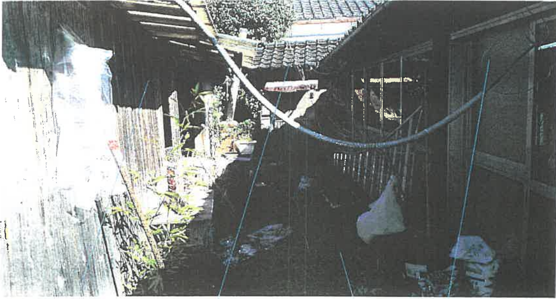
物件3 未登記附属建物トイレ
