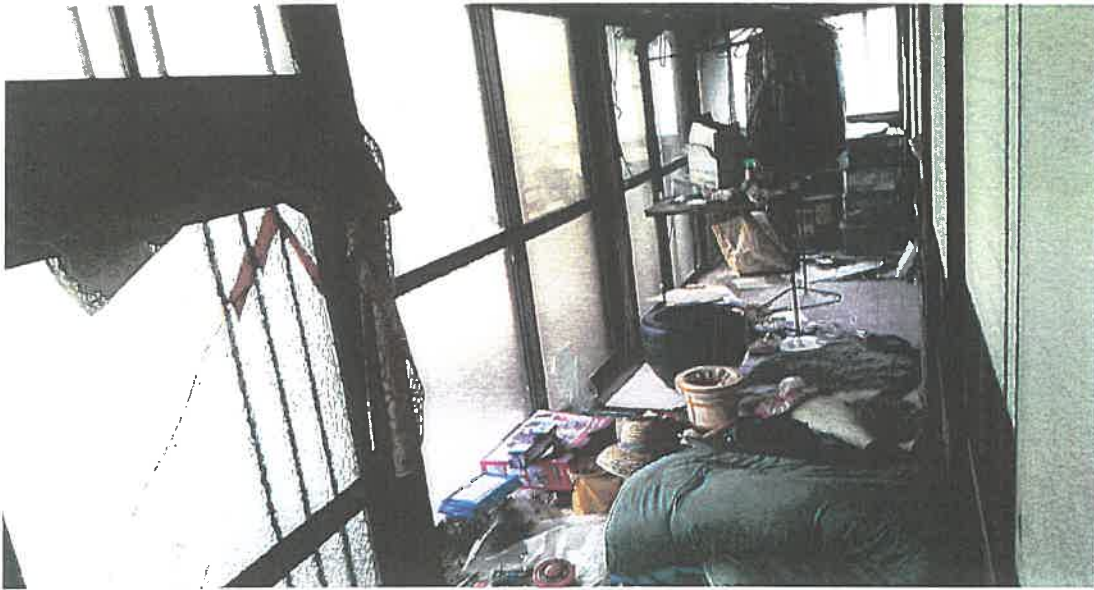
物件3主たる建物内部状況
